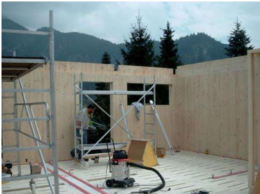
die vorgefertigten Holzelemente werden aufgestellt
